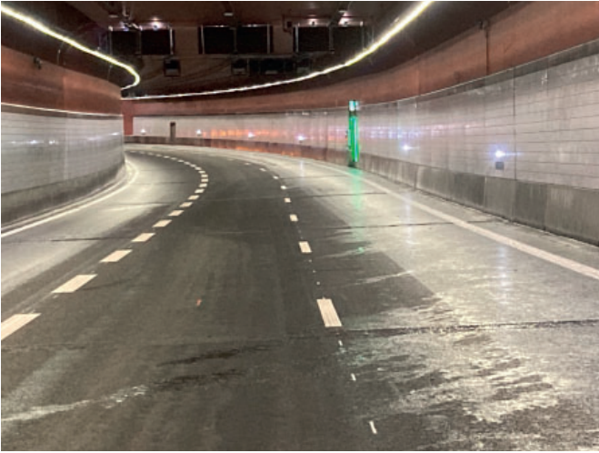
Mariefholmstunnel Göteborg Schweden
